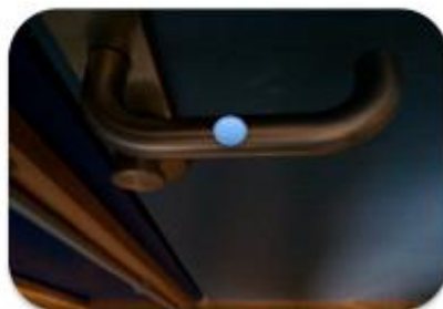
F1 Poignée de porte intérieure chambre
